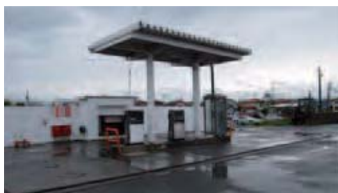
写真19-5 「給油設備」 日ノ丸自動車株式会社
