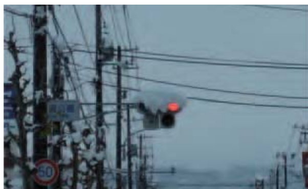
写真4-3 「雪の鳥取市内③」 雪で埋もれた信号機。重さで曲がってしまうものも。ストックホルムの信号機と比較すると、縦型にも理由があるのかもしれない。
