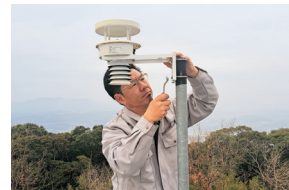
気象観測機器の設置
