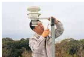
気象観測機器の設置
