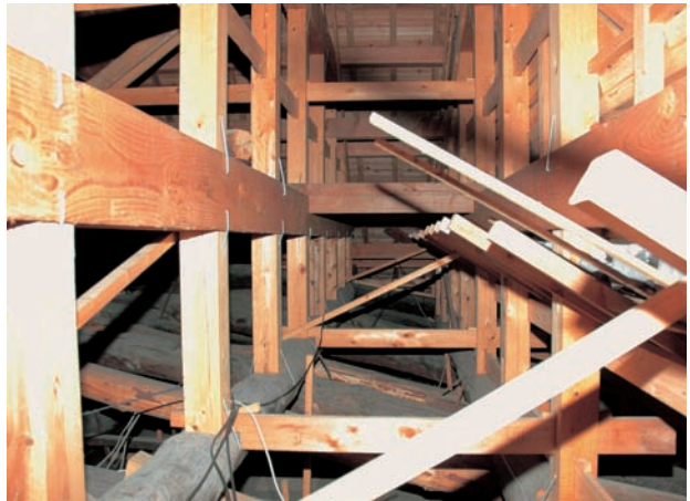
写真7 小屋裏 桔木までは古材 それより上は新材
