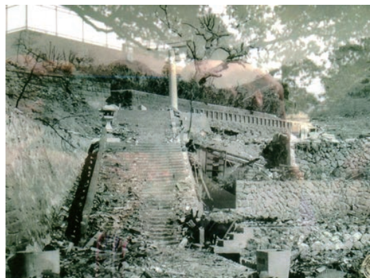
写真10 破壊された山王神社の参道 64)
