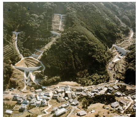
写真4 平成4年時、砂防ダム、排水路が完成 62)
