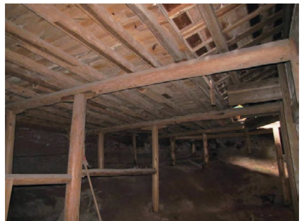
図10 甘露寺一段目の建物にみられる懸造の構法(床下)
