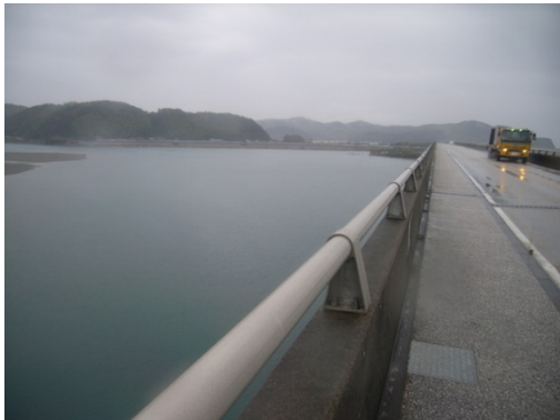
写真 2-3 放流地点の反対側（陸側、東方向）
