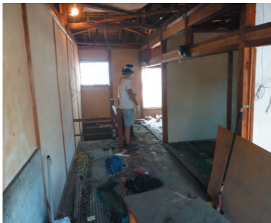
2F 廊下工事前
