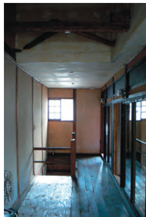
2F 廊下工事後
