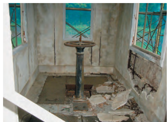
濾過池調整井上家・内部
