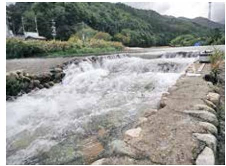
図8 用瀬発電所堰の魚道の写真
