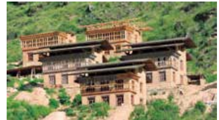
図-3 建設中の施設（ツァルイ寺）
