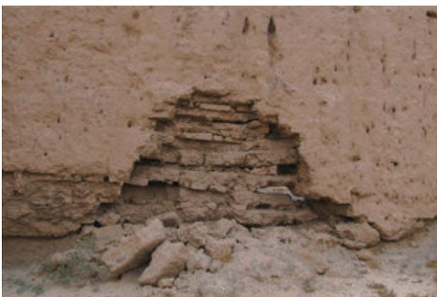
図30 日干煉瓦と砂礫土を交互に積み上げる構法
