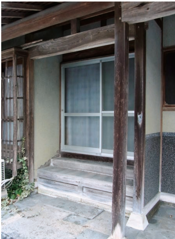
図10 1階床レベルとの段差（式台）
