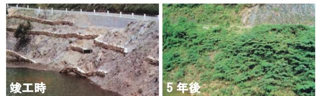
写真24 法面に竹柵を組み、表土を撒き出す<sup>(35)</sup>
