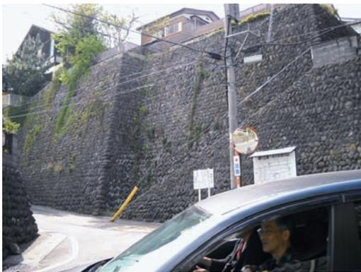
写真23 高さ10m程の犬走りのない直積みに近い石積み
