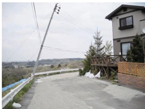
写真20 傾いた電柱
