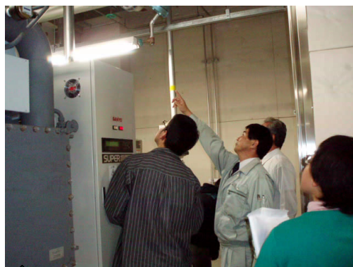
↑ メディアセンター地下の機械室を監査している様子
